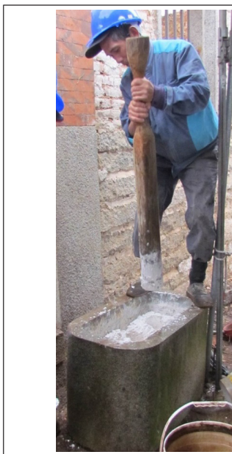
【圖11】蚵殼灰舂灰過程
