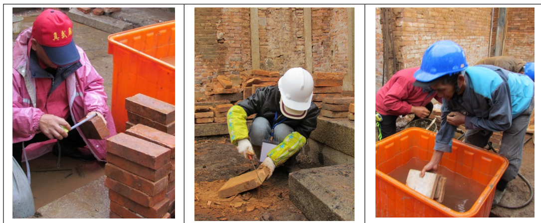
【圖39】挑（撿）磚，依尺寸分類，確保每勻高度一致
