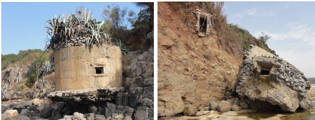
圖5 國軍海防陣地海濱碉堡磚石填方基礎崩解選例： 南山頭營區（普查編號176）東側及西側
