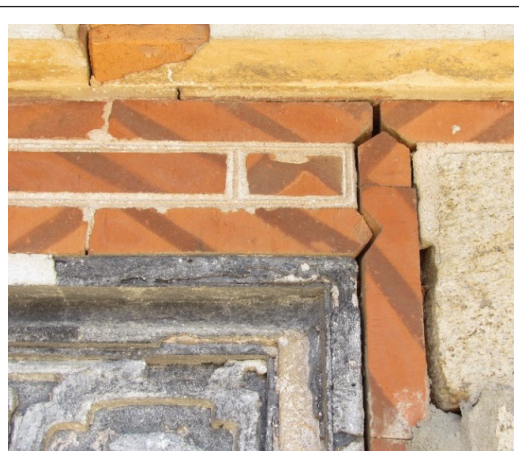
【圖51】磚牆砌作收邊用於分隔兩種不同紅料砌作，或是兩種不同材料時使用。
