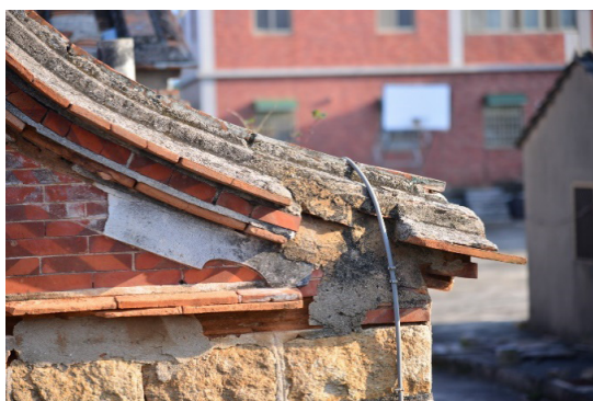
圖30 右擗頭規尾檐口出料破損
