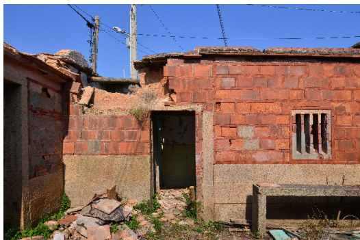
圖32 牆身為斗砌牆牆基為封堵石
