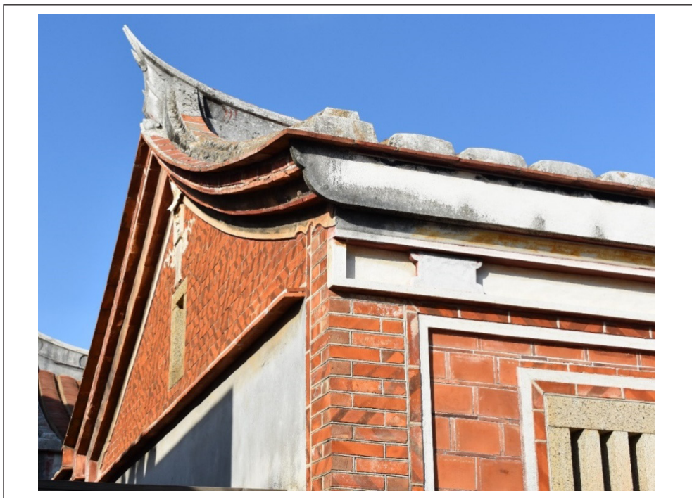
【圖49】平砌磚牆砌作亦用於轉角
