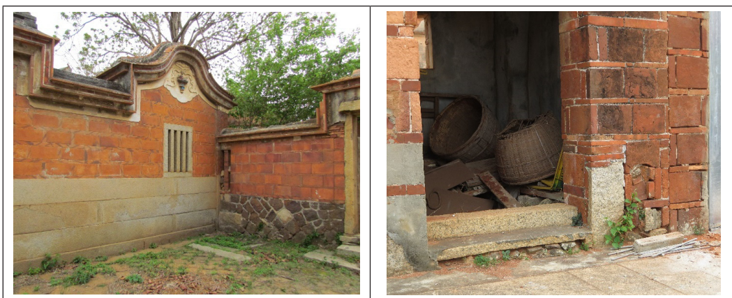
【圖36】「甃」砌作因使用甃磚而稱之，如同臺灣傳統建築「斗子砌」砌法
