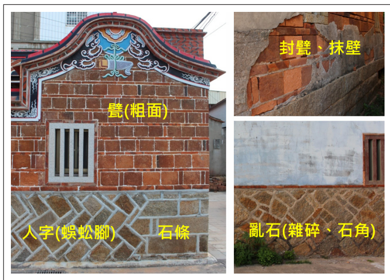
【圖25】 金門傳統建築外牆面構築式樣
