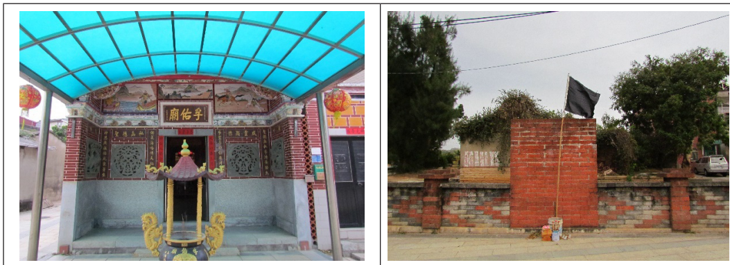
【圖6】東洲孚佑宮，西司第一個獨立承包的工程
