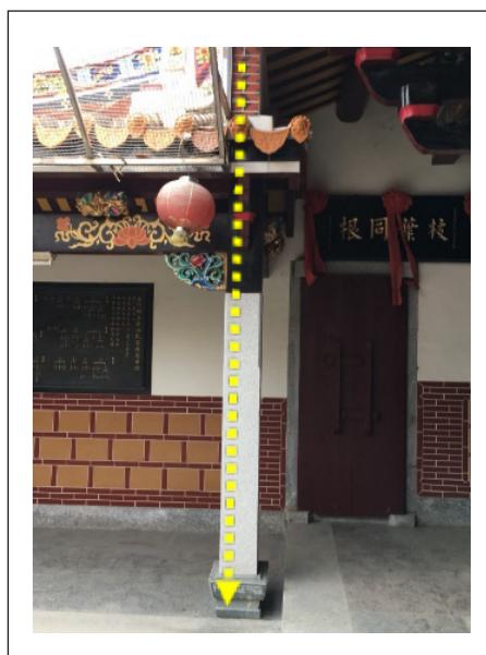
圖84 雨水於後落不得滴到踏腳石
