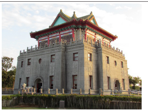
圖15 翁水千施作的莒光樓鋼筋水泥棟架
