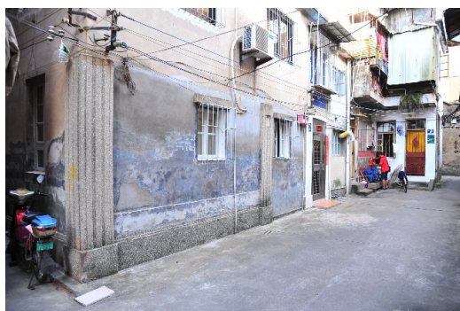
圖4 廈門呂世宜故居範圍 ——留有原洋樓之牆基立柱
