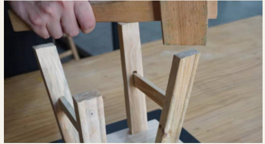
2. 將凳腳置於椅凳背面， 依正確方向使用木槌敲擊組裝
