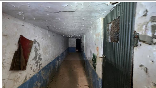
【圖 13】主空間 3 外坑道現況
