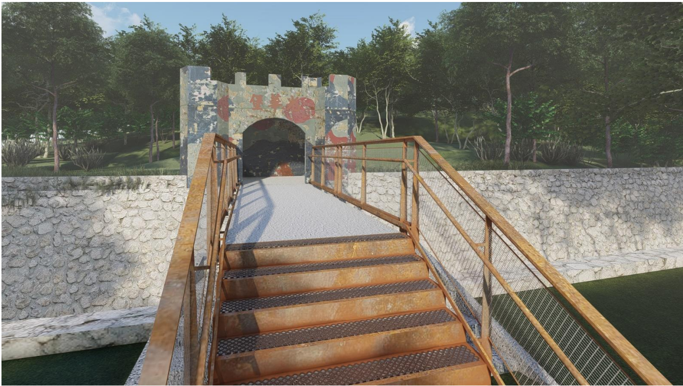
光華堡橋梁欄杆踏階改善
