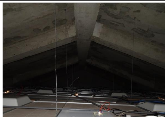
【照片 2-4】RC 屋架與樓板（屋面板）現況
