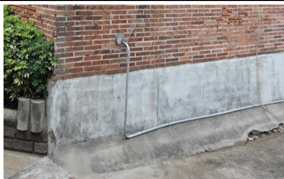
【照片 2-8】禮拜堂臺基情形
