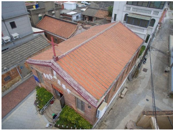
沙美基督長老教會禮拜堂屋頂修復前
