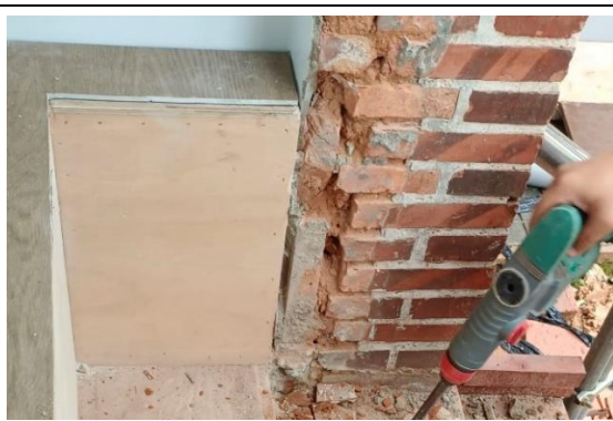
【圖 2-9】本案拆解後發現之壁體構法
