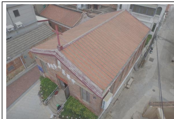
【照片 2-3】沙美教會屋頂瓦作現況 (一)
