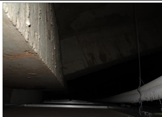
【照片 2-5】RC 屋架與牆體交接處現況
