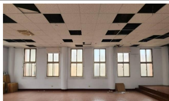
【照片 2-6】新設之半圓形 RC 柱體
