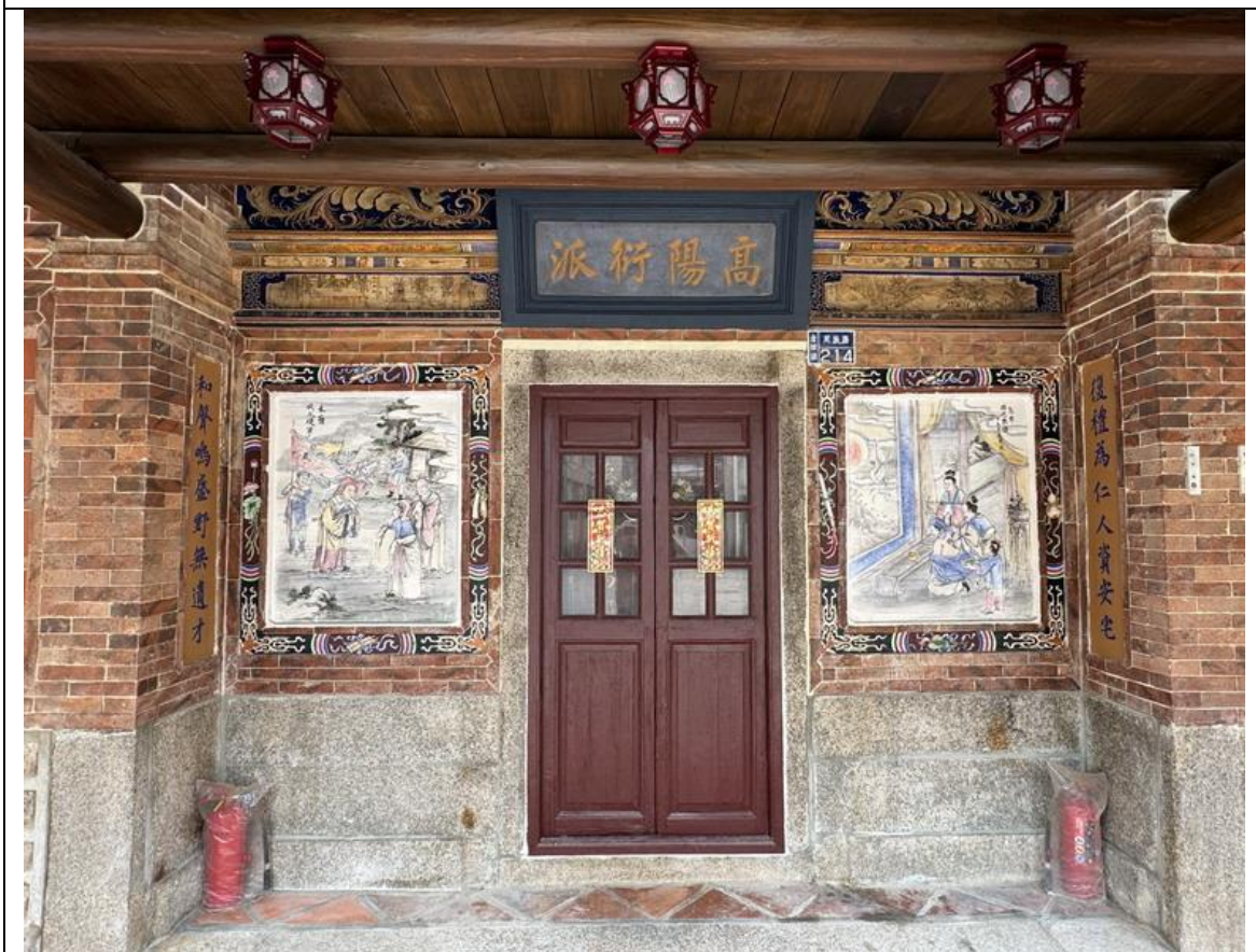
五腳基廊道入口處修復後
