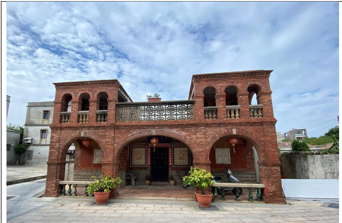
正立面修復前
