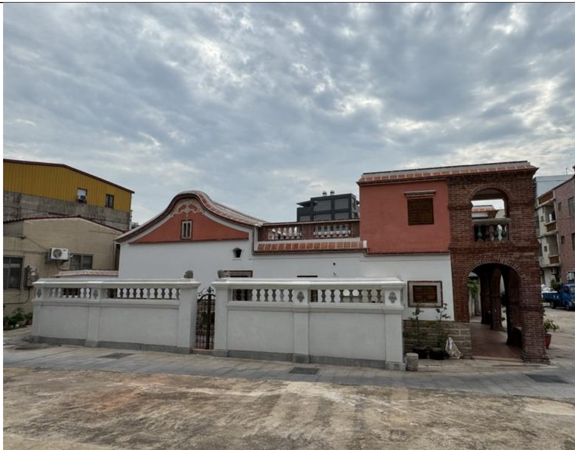
西向立面修復後
