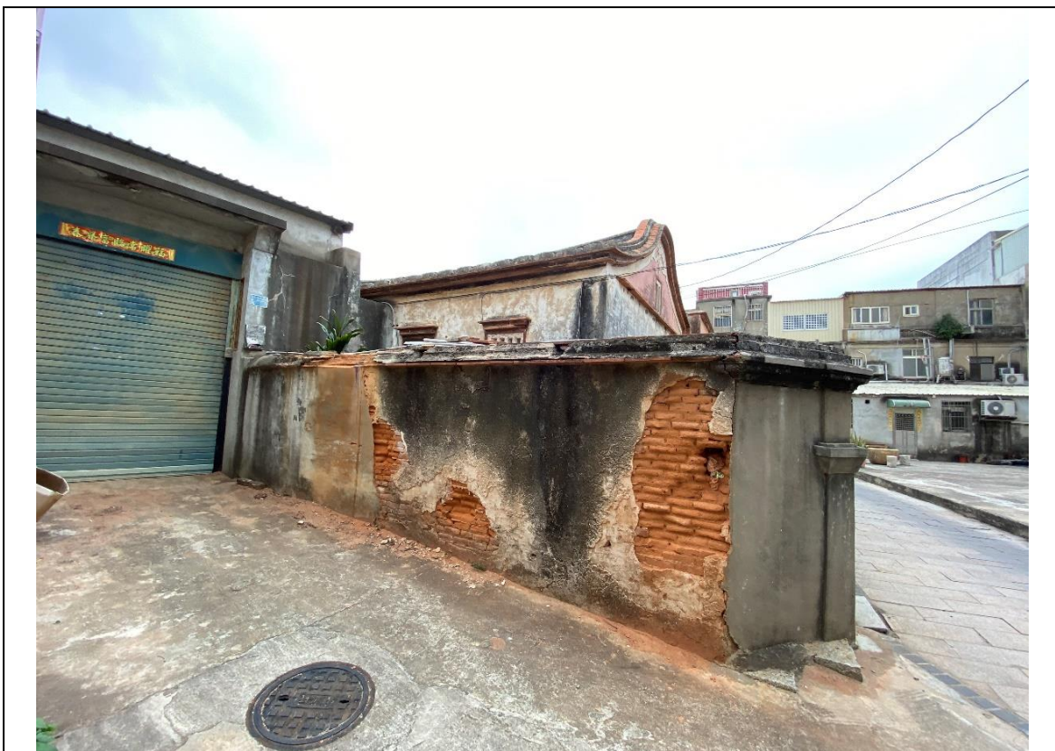
南向立面修復前
