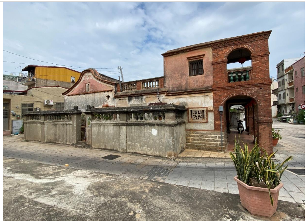
西向立面修復前
