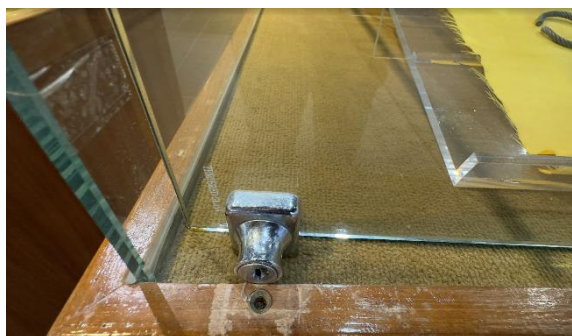
圖 17 文化館內展櫃鎖頭位移、脫落
